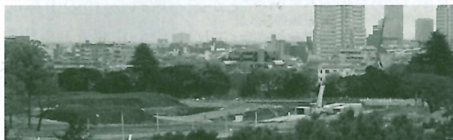
工事中の風景 (2017年12月) 現れた広大な敷地の一部
