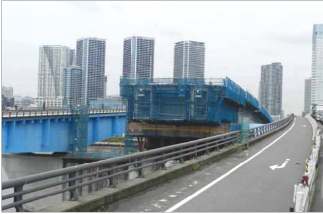
晴海大橋に挟まれる首都高速晴海線（工事中）
