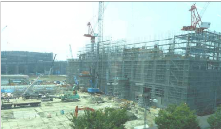
東京都が急ピッチで進めている豊洲新市場の工事=2015/8/2
