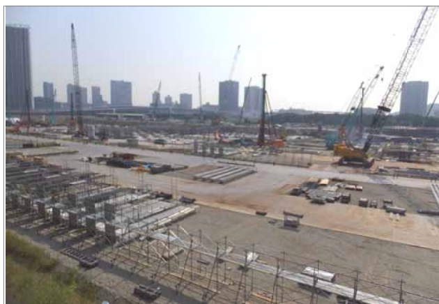
まだ既存杭撤去などの基盤整備工事をしています=9/30
