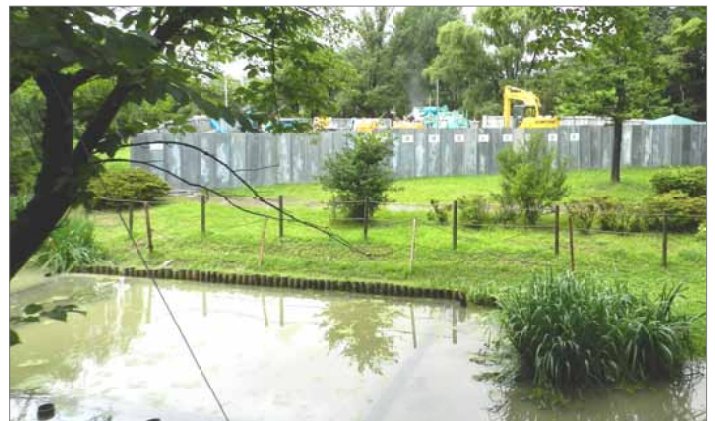
香久池公園内に囲いを作った仮置き場整備工事
