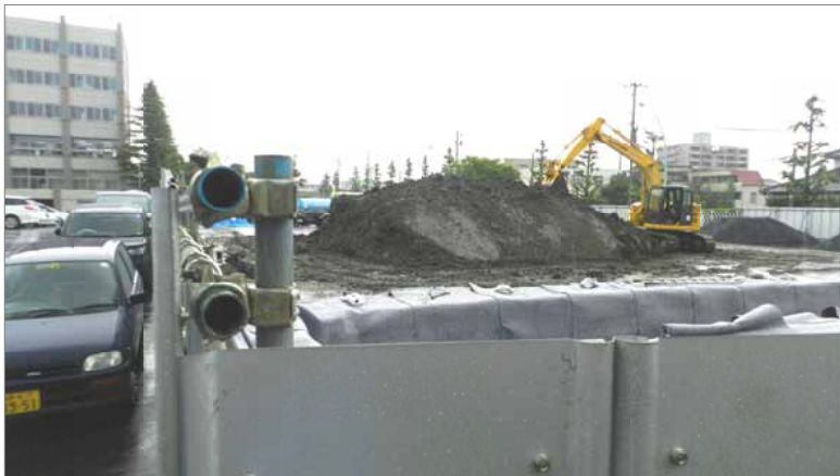
市役所周辺の道路除染で出た土などを保管＝市役所駐車場
