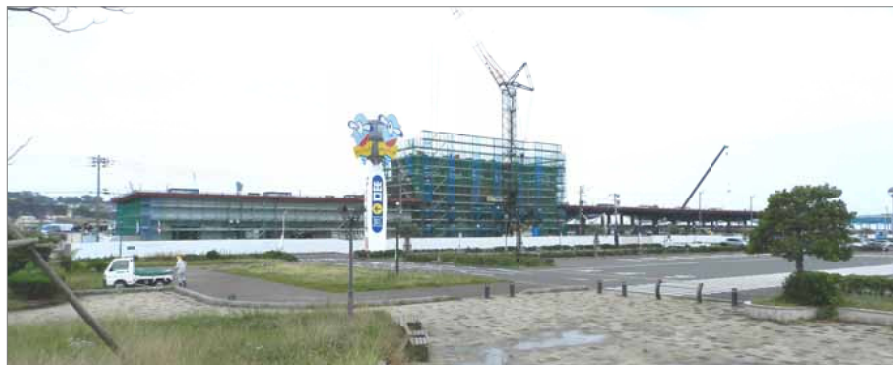
写真② 建設中の製氷・冷蔵庫施設。
