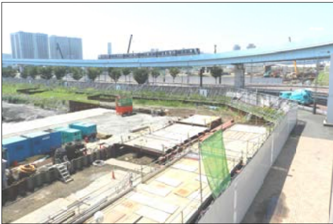
ゆりかもめからよく見える土壌汚染対策工事の様子。
