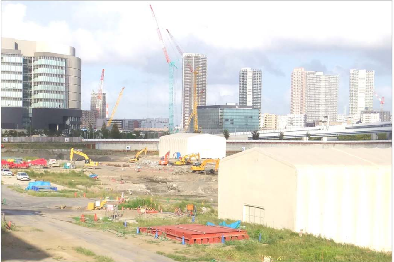
青果仲卸の建設が予定されている第5街区での土壌汚染対策工事の様子です。= 9/17 撮影
