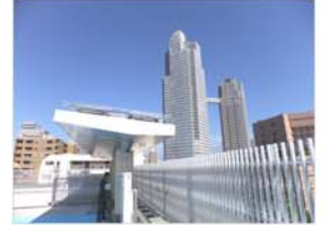
屋上の太陽光パネル
