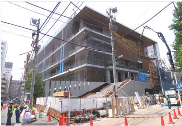
以前の面影がなくなった中央小の外観です。
