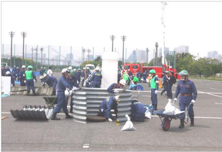
マンホールからの出水を防ぐ「マンホール噴出防止工法」
