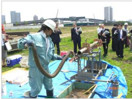
ボーリング調査を視察＝08年5月
