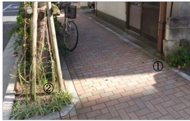
0.68は②から。雨樋①から雨水が集まったようです
