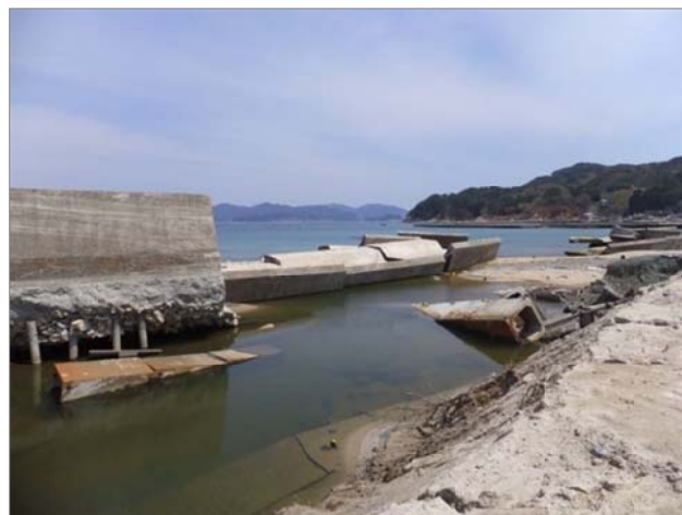
破壊された防潮堤。津波の威力を示す海辺の様子です。
