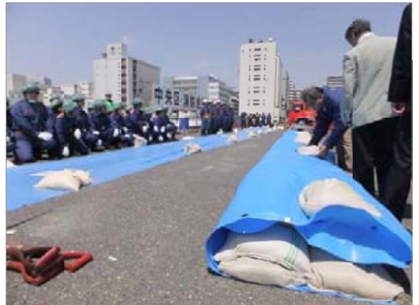
堤防を越える水を防ぐ「改良型積土のう工法」
