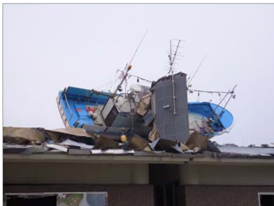
海（右写真の左方向）のそばに建っている下水処理施設の屋根に小型船が乗っていました。排気筒への引っかかり具合を見ると引き波の時にひっかったようです。
