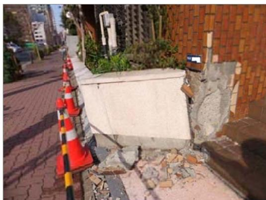
歩道が沈下し、マンションの玄関部分が破損
