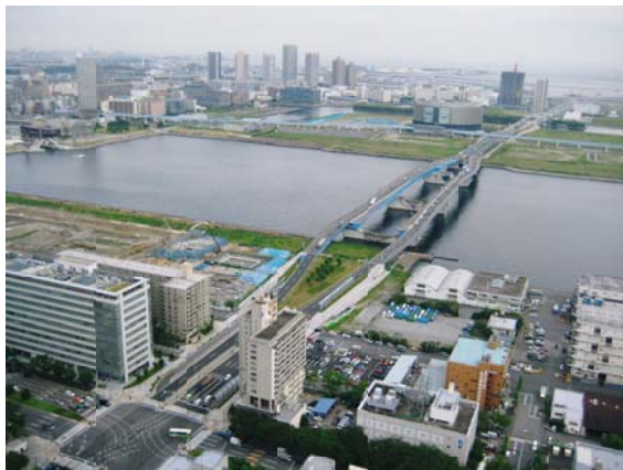
高速晴海線が計画されている晴海大橋
