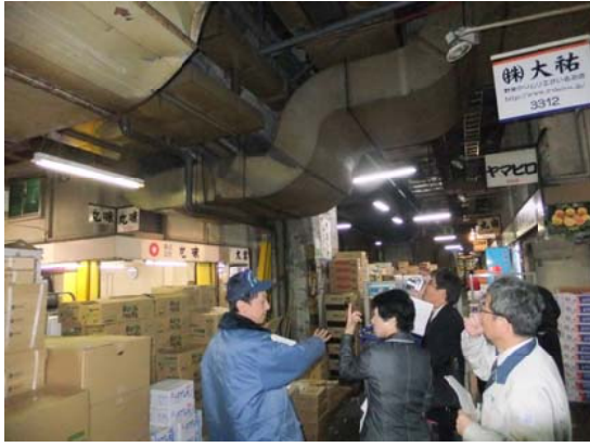
以前から雨漏り対策で都が設置していたトイレ
