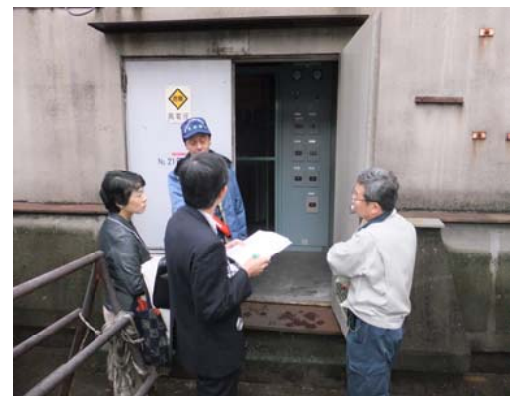
変電施設も調査しました。
