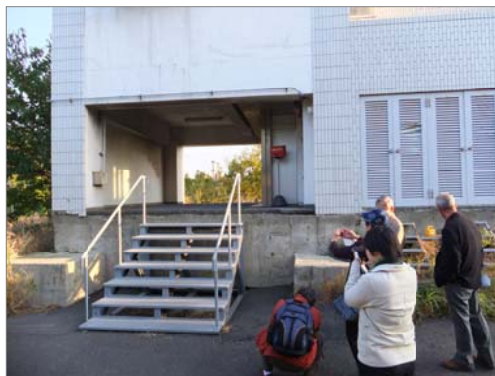
地盤の悪い東京港の埋立地は、少しずつ沈下しています。それが一目で分かる大田区城南島海浜公園内の大井信号所の建物に行きました。1980年から30年間で約1m50cmも沈下しました。中央の階段の上が当初の地面でした。
