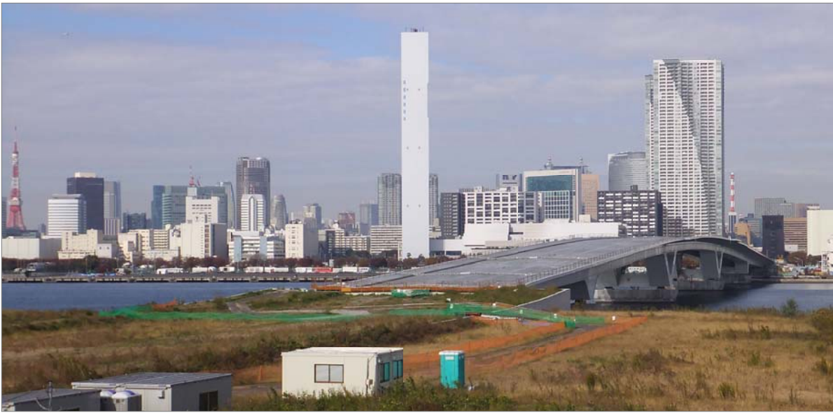
環状2号線を通すために建設中の「豊洲大橋」。豊洲の ゆりかもめ「市場前駅」から写しました。
