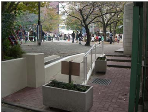
(現在) スロープに直し、車椅子でも上げられるように手すりも付きました。
