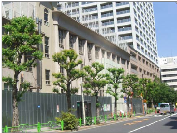
解体工事が始まった明石小学校=31日撮影
