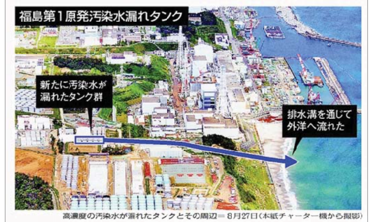
連日報道される汚染水漏れ。上は3日発表の事故
