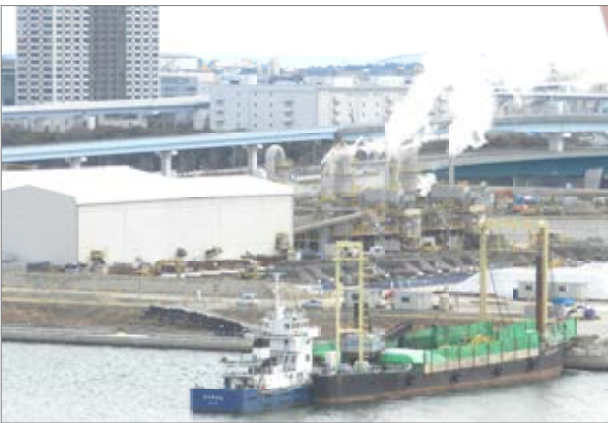
6街区のプラントからは水蒸気が…＝晴海側から
