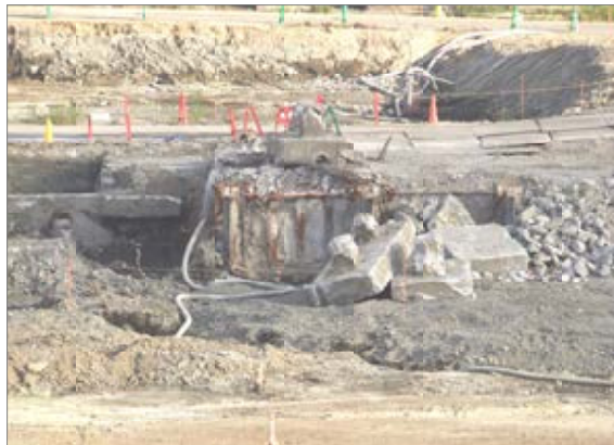
豊洲の土壌汚染対策工事。露出したコンクリートの杭（左）や基礎（右）＝2012年9月17日
