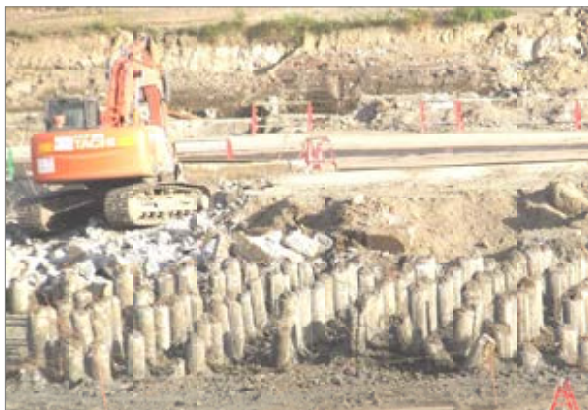
豊洲の土壌汚染対策工事。露出したコンクリートの杭（左）や基礎（右）＝2012年9月17日
