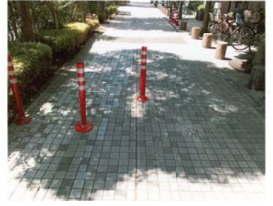
右側の2本が破損したポール（補修前の様子。つくだ保育園にて）
