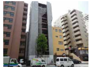
建設中の高齢者向け優良賃貸住宅「Y・S日本橋浜町」(写真中央)
