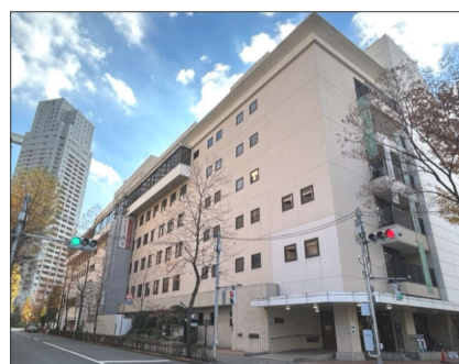
子ども家庭支援センターが移設される保健所の建物。現在改修工事中。
