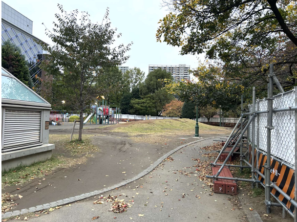
④写真：築山を平坦にする工事の準備（11/12撮影） ⑤図：広場工事の位置図（お知らせ看板より）
