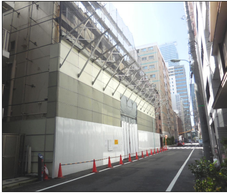
解体工事が始まった旧山村病院の建物
