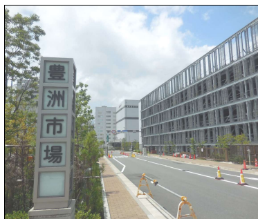
豊洲市場（7街区施設管理棟） ＝7月29日おぐり撮影
