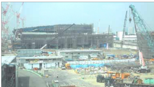
豊洲新市場の工事現場=8/3、おぐり撮影
