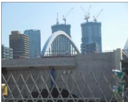
オリンピックの幹線道路となる環状2号線の市場側取り付け部。アーチは橋の上部。奥は晴海。
