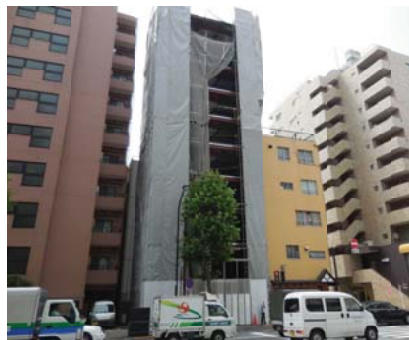
建設工事中の高齢者優良賃貸住宅「Y・S日本橋浜町」(写真中央の建物) =6/10おぐり撮影
