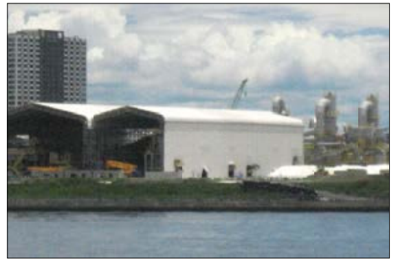
豊洲市場予定地にある汚染土壌洗浄プラント。 12/6/10 晴海埠頭から、おぐり撮影。
