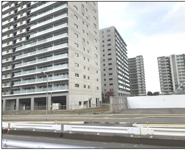
東京2020大会時に選手村となる晴海5丁目ハルミフラッグの約3700戸の板状住宅棟
